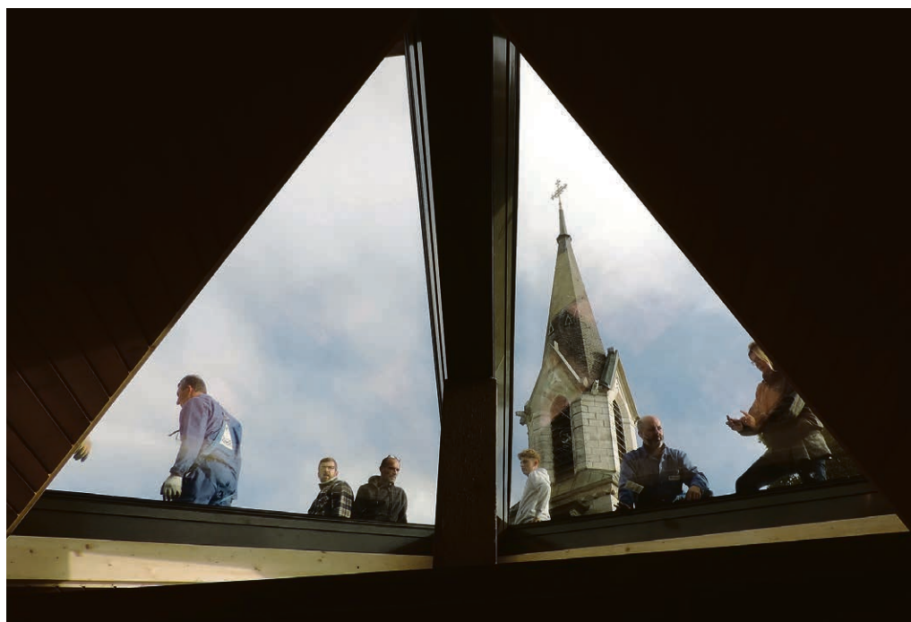
Saint-Saphorin Centre paroissial, ouverture sur l'église.
